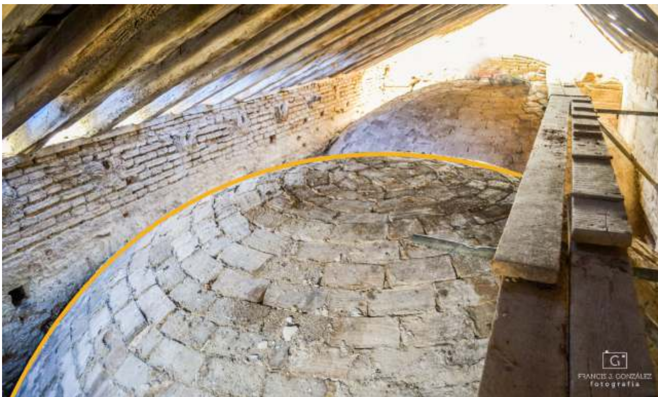
Interior de la nave construida por Cristóbal Ruiz Florindo en Santa María la Blanca.
