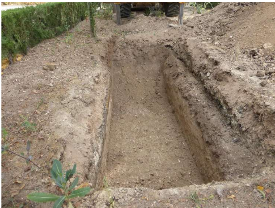
Proceso de excavación del sondeo 2.
