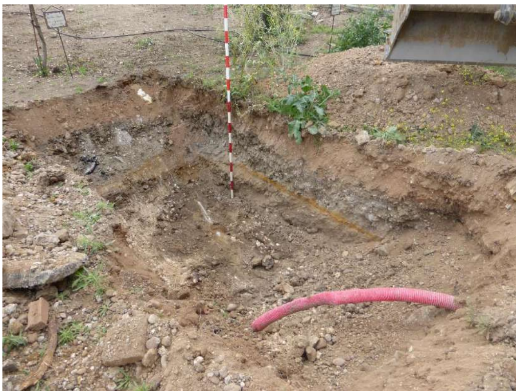
Excavación del sondeo 8 donde se aprecian infraestructuras del cementerio, acometida de agua.
